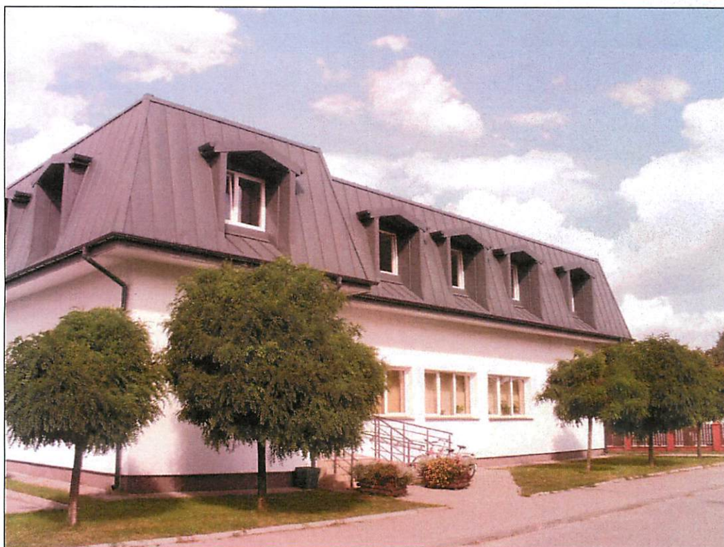
Ryc. 17. Budynek Gminnej Biblioteki Publicznej w Firleju.
