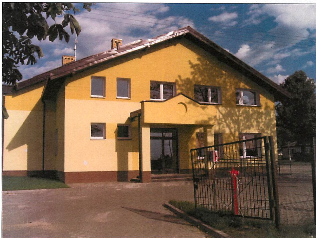
Ryc. 18. Świetlica wiejska wraz z biblioteką w Woli Skromowskiej.
