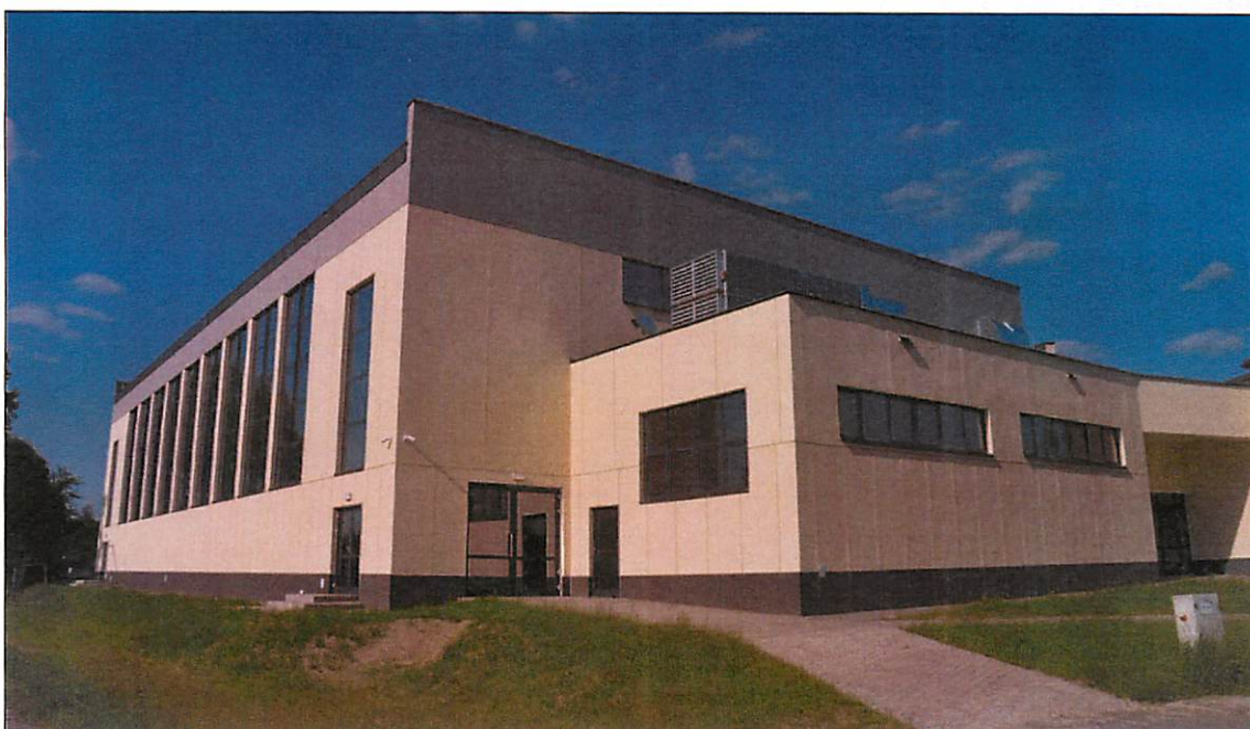
Ryc. 15. Sala gimnastyczna przy Zespole Szkół w Firleju.
